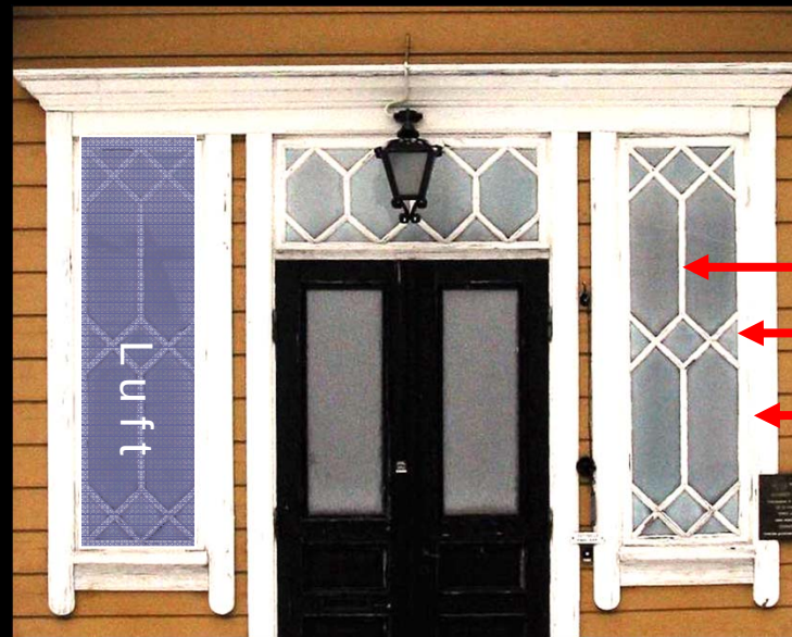
T.v. delarna i ett fyrlufts-fönster
